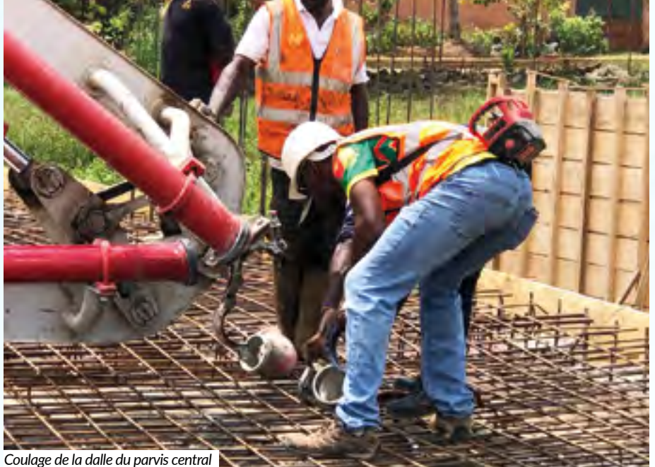
Coulage de la dalle du parvis central
