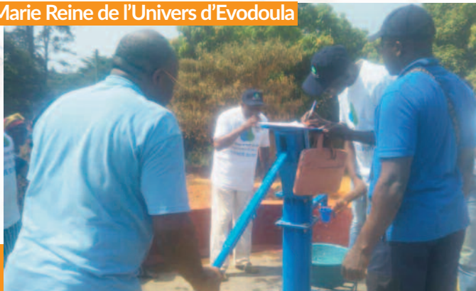
Don d'une pompe à eau potable, 04 janvier 2023
