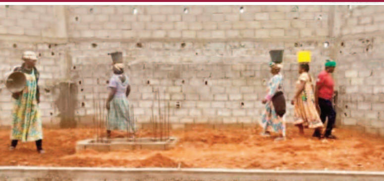
Seau après seau, les travaux avancent grâce à la mobilisation des paroissiens
